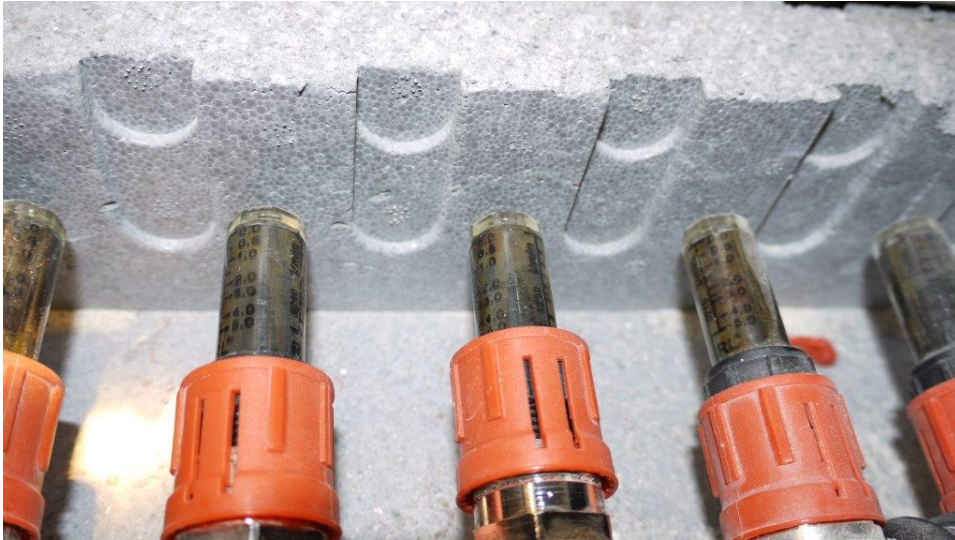
Verschlammte Durchflussanzeiger
